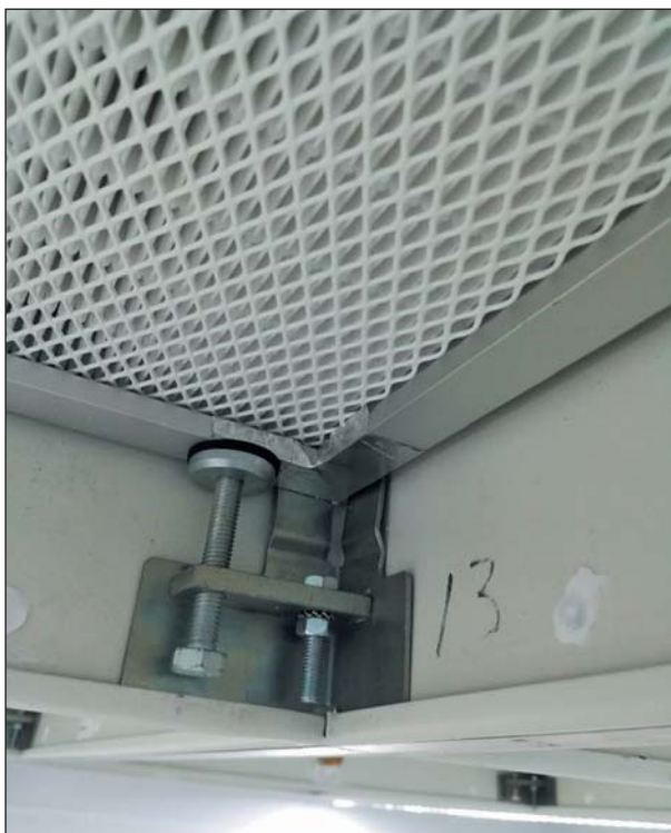
Рис. 2. HEPA-фильтр с поддерживающей сеткой
